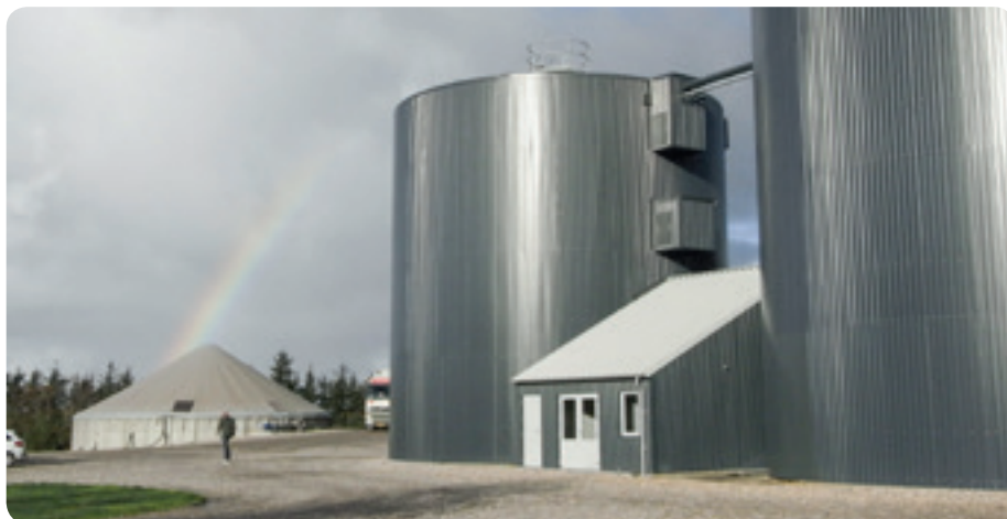
ComBigaS var et af anlæggene i undersøgelsen.
